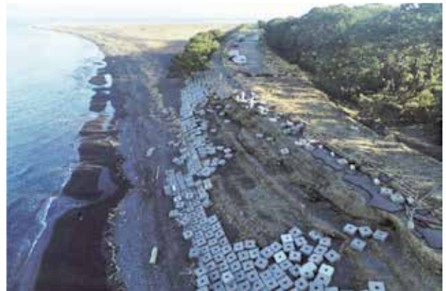
静岡県 清水海岸の被災状況（写真提供：静岡県）
