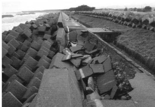
激しい高波により海岸堤防等が倒壊
