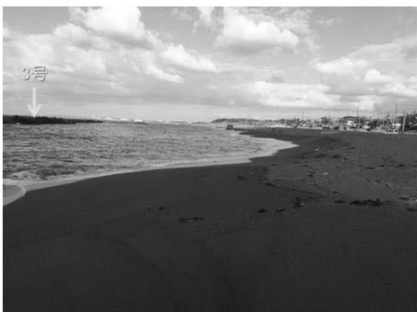
写真-3 2, 3号堤間の開口部での汀線後退
