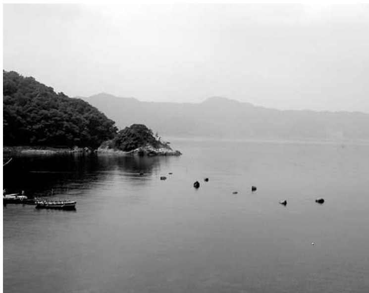
写真-1 人工リーフ天端を露岩で型取る様に配置した例
